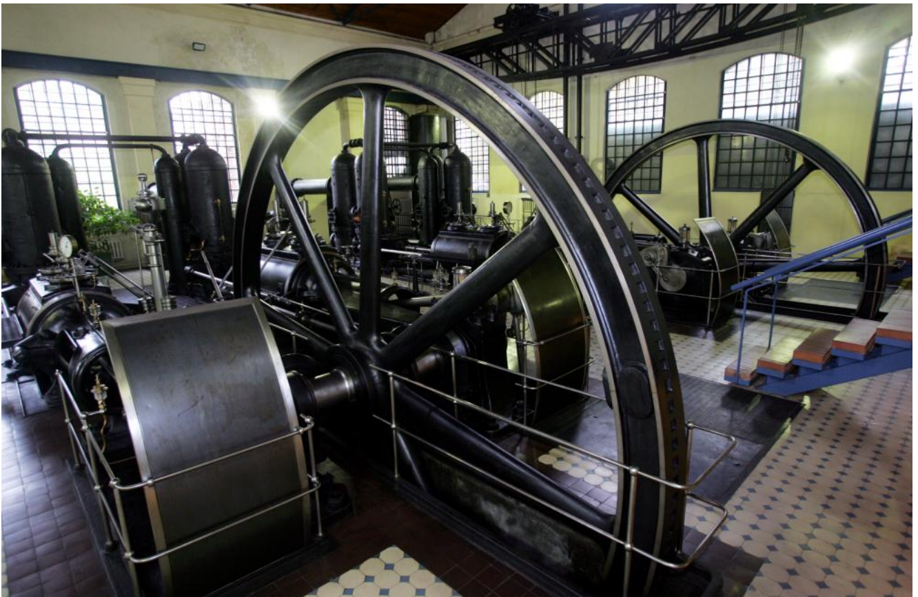
Rīgas ūdensapgādes vēstures ekspozīcija sūkņu stacijā "Baltezers"
